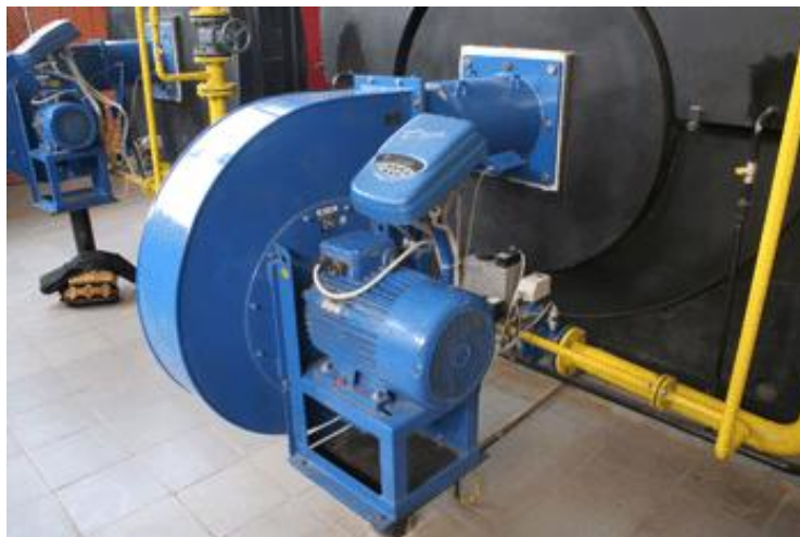
Fig. 1. Arzătorul de gaze naturale de tip „DAVA” cu funcționare la sarcină variabilă
