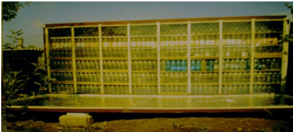
Рис 1. Аккумулятор явного тепла с непосредственным поглощением солнечного излучения (3000 рабочих тел в виде 1,5л. пластиковых бутылок с водой).
