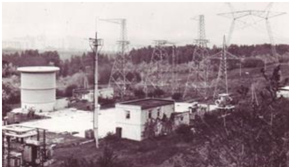
Рис 10. Высоковольтный полигон: ГИН-2500 кВ, ИТ-500 кВ, две фазы УСВЛ-500 кВ на опоре ВЛ-550 кВ (УСВЛ-500 кВ содержит 2 трехфазные цепи, общее число фаз равно 6, показаны 2). 10
