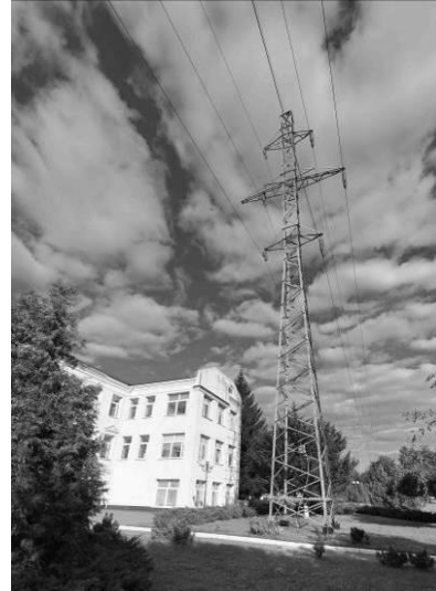
Рис.1. Жилой дом, расположенный вблизи двухцепной ЛЭП. 1
